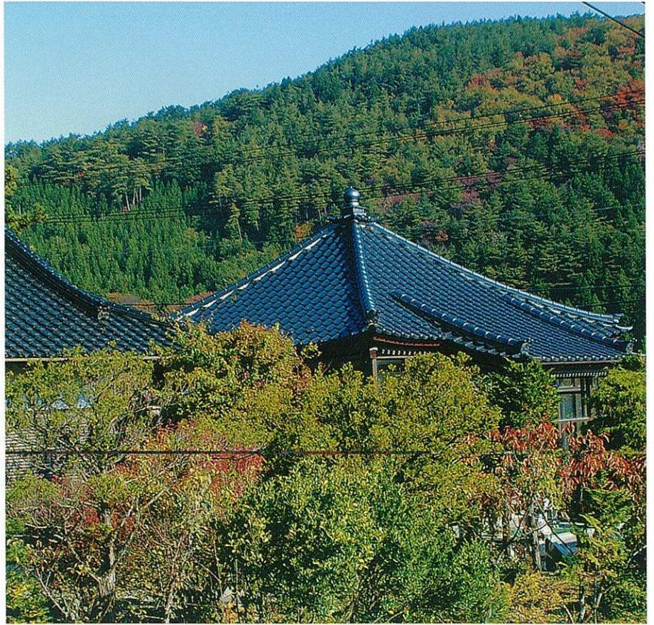
母屋とあまり変わらない規模を見せる持仏観音堂の鞘堂
